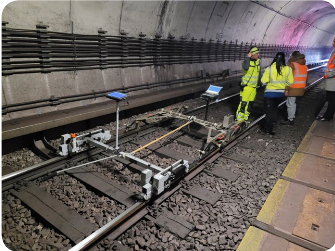
Nachprüfung der gefrästen Schienen
