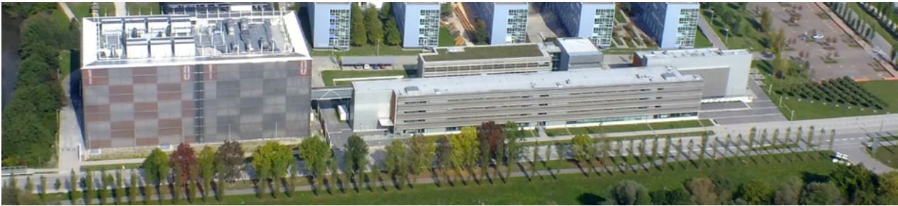
Luftaufnahme des LRZ (vom 03.10.2011, von Ernst Graf). Von links nach rechts: das Rechnergebäude, das Bürogebäude, Binärdarstellung aus Bäumen und Steinen
