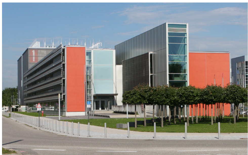
Das Leibniz-Rechenzentrum (August 2011, mit Erweiterung). Foto: LRZ
