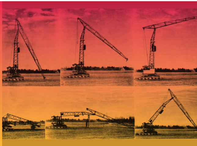
erster mobiler Turmdrehkran
